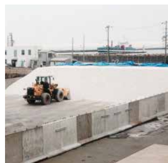
● コンクリート擁壁
